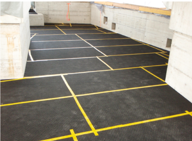
Bain thermal et spa au-dessus d'un bâtiment commercial: appui en ISOPOL®
