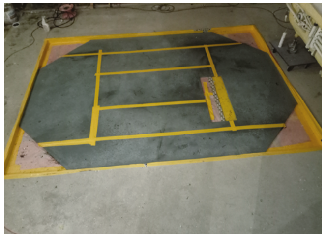
Baignoire octogonale: isolation avec une plaque de répartition de charge composée de segments de tôle en acier pour une faible hauteur d'installation
