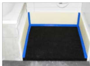
Pose des nattes d'isolation acoustique ISOPOL® ou ISOLMER®. Collage des joints sur les bandes de rive avec du ruban adhésif pour béton
