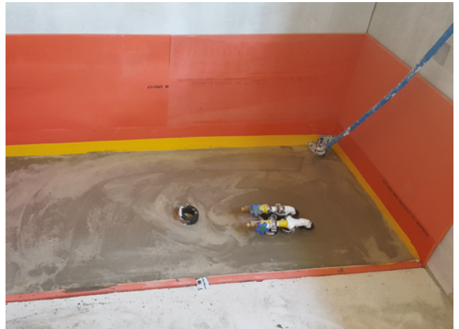
Baignoire rectangulaire : socle de répartition de charge isolé et fraîchement bétonné
