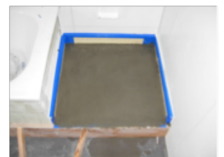
Coulage du socle de répartition de charge
