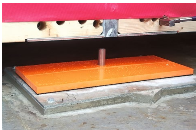
Abaissement du cube en bois sur un point isolant en ISOLMER®.
