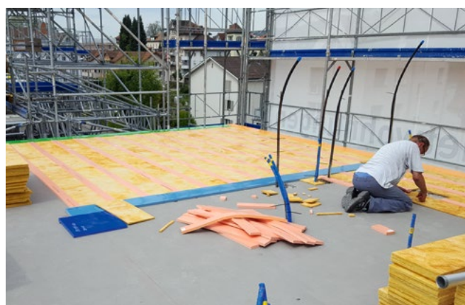
Pose des bandes ISOLMER® et de l'amortissement des cavités
