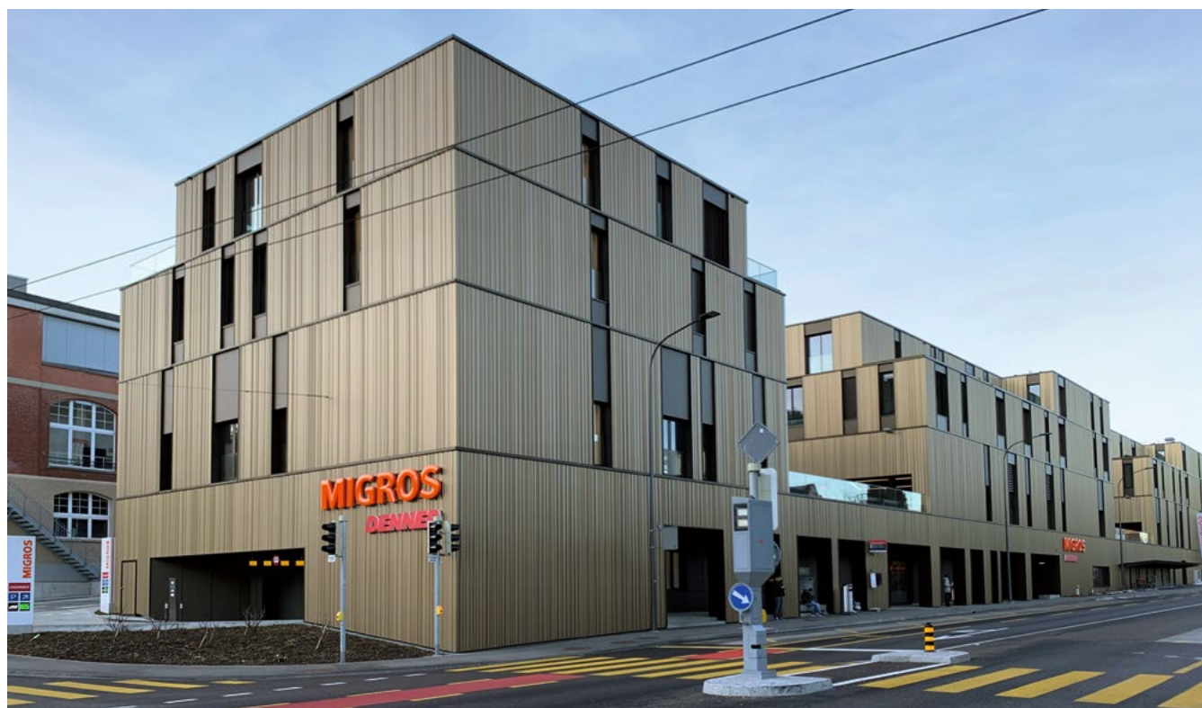
L'objet Migros Bruggen à Saint-Gall a été pourvu d'un système d'isolation contre les vibrations et les bruits solidiens
