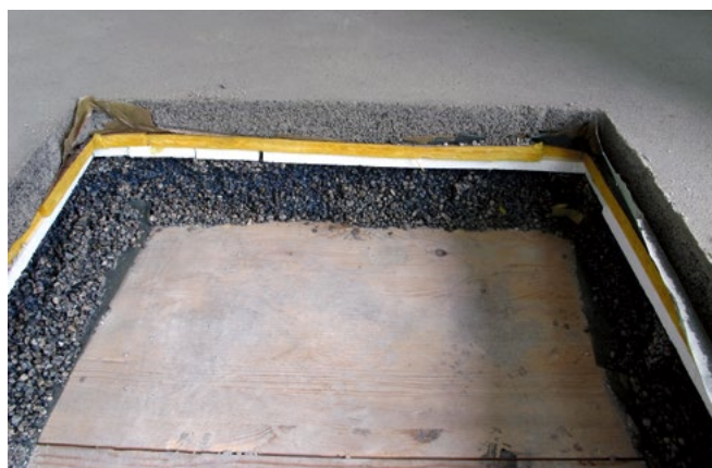
Dans les salles d'eau des planchers en bois massif ont été posés sur des planches préfabriquées
