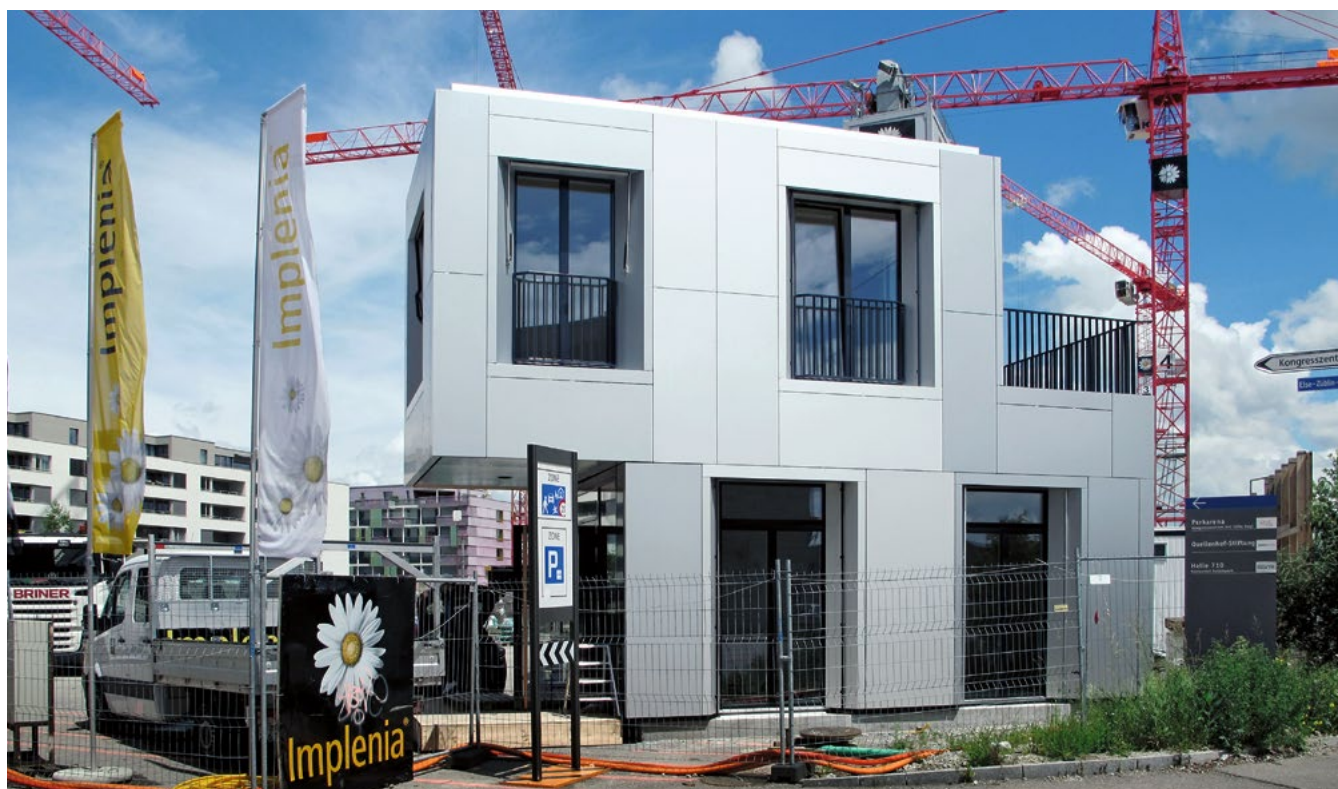
Logements en propriété et en location – lotissement « Sue & Til » Winterthur, les salles d'eau ont été posées sur des nattes en polyuréthane
