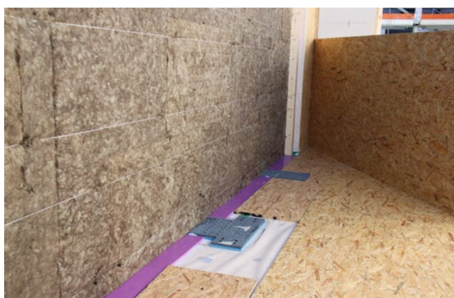
Les parois en bois reposent sur des appuis en nattes ISOLMER®
