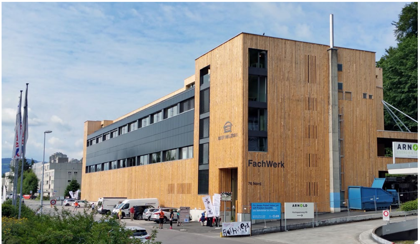
Hall de production avec bureaux et appartements dans les étages
