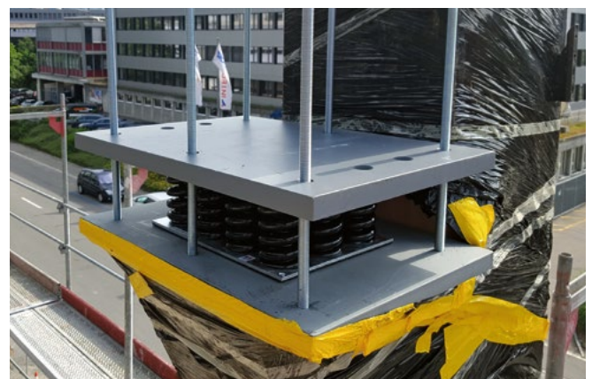
Montage des appui élastiques ISO FED®
