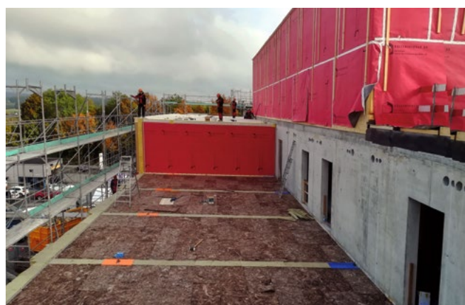
Les modules en bois sont rapidement posés par une grue sur des nattes ISOLMER®.
