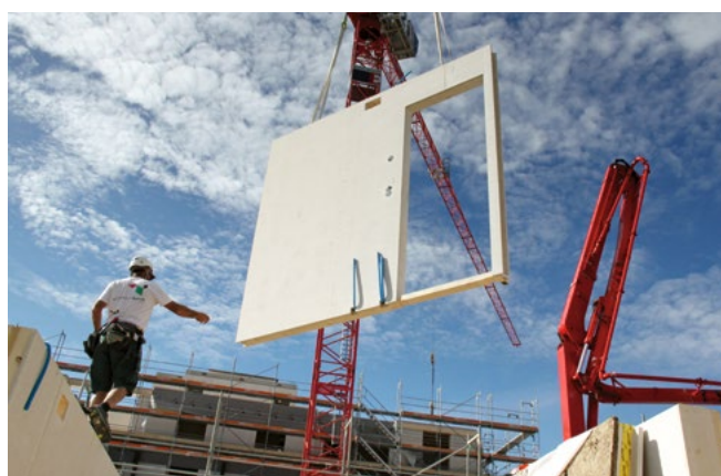
La grue place les parois préfabriquées directement sur les appuis en bandes ISOLMER®
