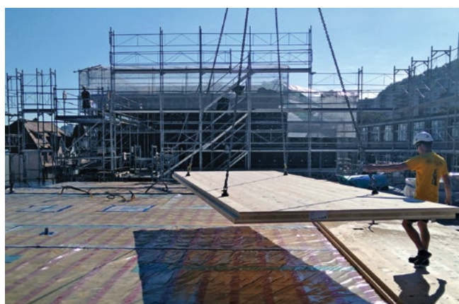
Pose par le client des panneaux de répartition des charges en bois sur les appuis en bandes ISOLMER®
