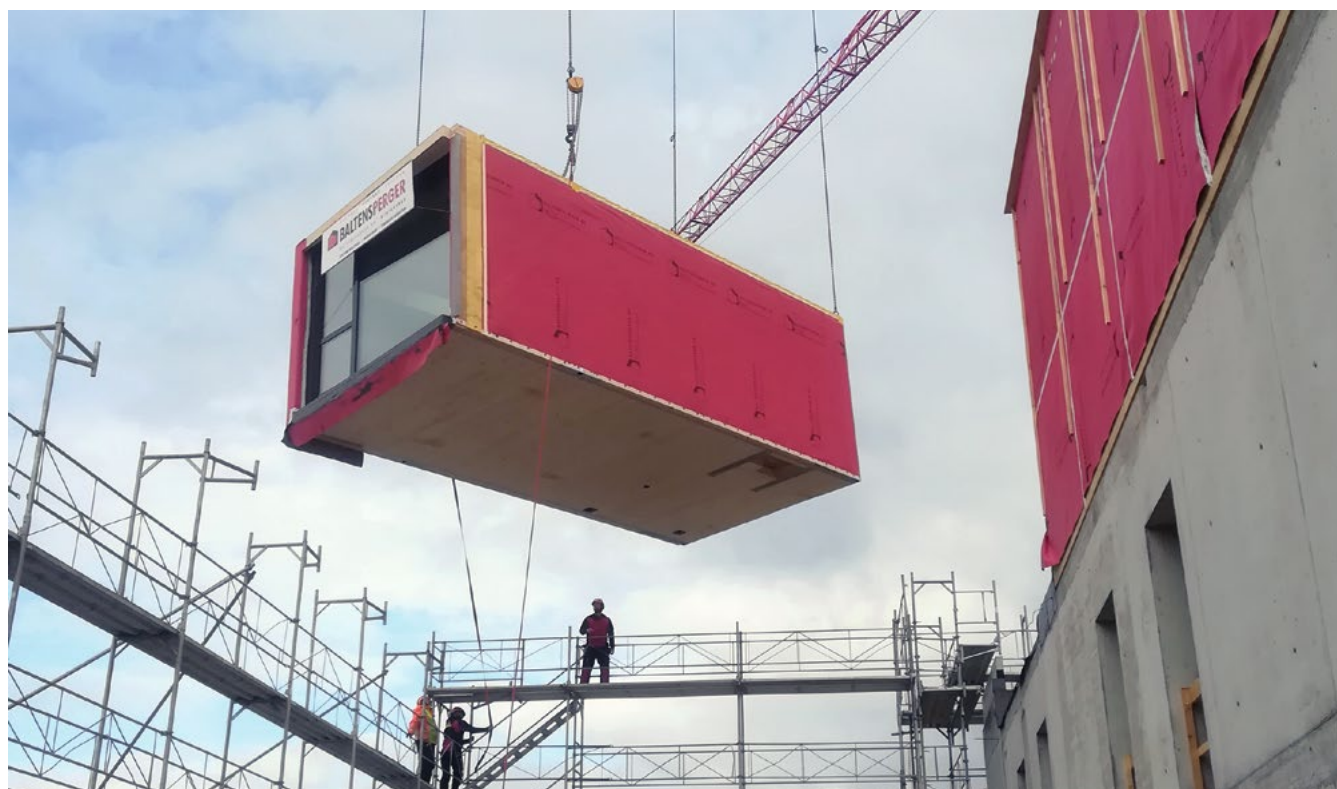
Les modules préfabriqués en bois pour l'hôtel Autohalle sont directement positionnés à l'aide d'une grue.
