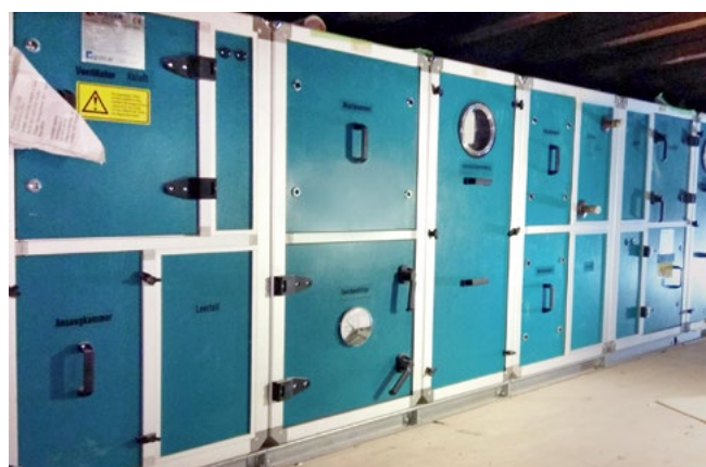
L'installation est à sa place définitive, encore sans éléments de suspension
