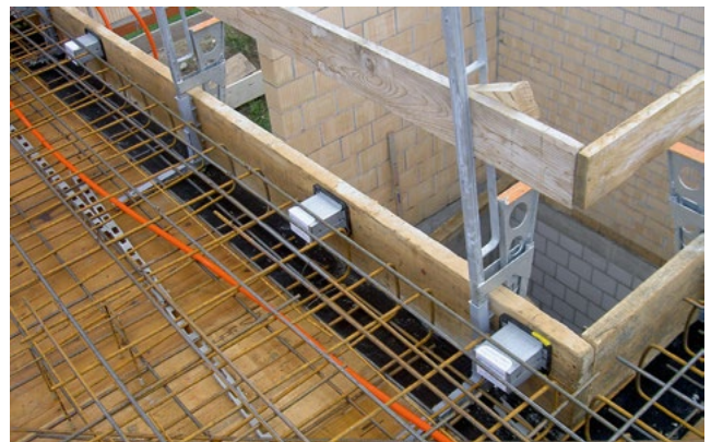
Bauweise Ortbeton: Die Schallschutzgehäuse ISOLA® 35 dB sind lagerichtig an der Abschalung zum Treppenhaukern montiert und werden in der Decke einbetoniert.
