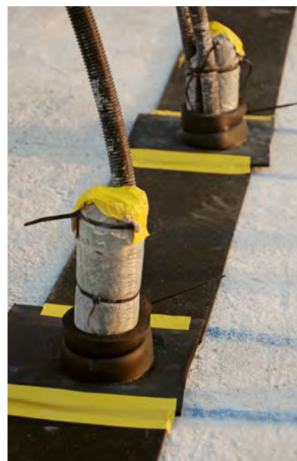
Passages de tuyaux dans la zone des ISONOVA® appuis de séparation acoustique avec ISOLINE-SPEEDY
