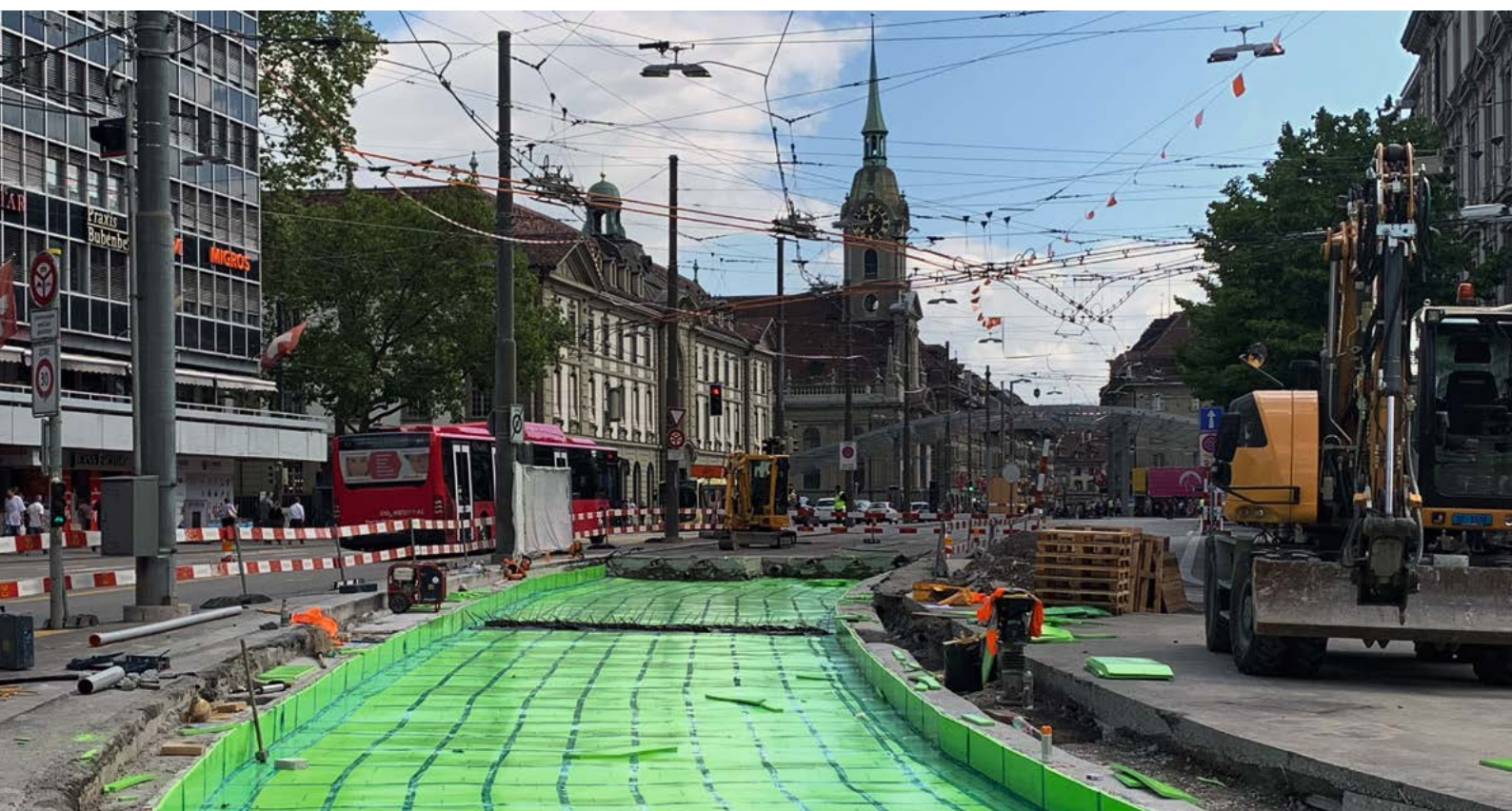
Masse-Feder-System mit Dämmmatten ISORAIL® MMS P in PUR-Qualität Système masse-ressort avec nattes antivibratoires ISORAIL® MMS P en polyuréthane
