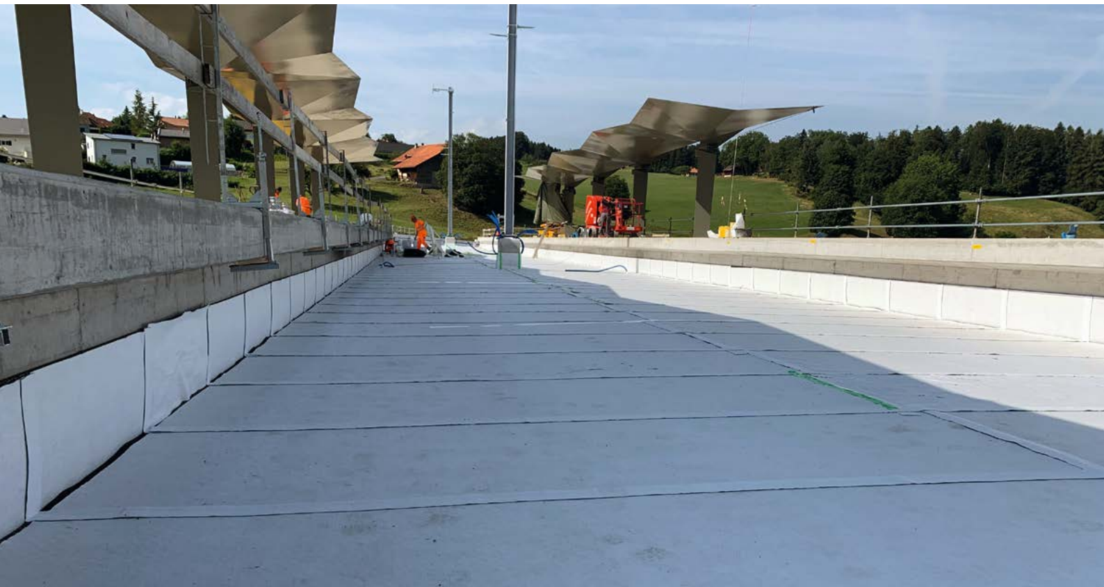
Unterschottermatten ISORAIL® SBM K in Gummi-Qualität / Tapis sous-ballast ISORAIL® SBM K en caoutchouc
