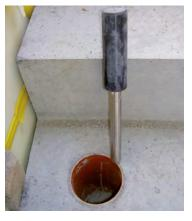
La broche d'assurage ISODORN, insonorisant des bruits solidiens, est introduite dans le percement de tube et dans le trou percé dans la dalle. Ensuite, le percement est bouché avec du mortier de scellement.
