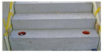
Élément d'escalier posé. Sur les côtés, séparation au moyen d'ISOPE. Au premier plan, coffrages cylindriques pour recevoir les broches absorbantes ISODORN.
