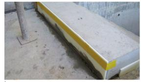
Éléments d'escalier installés. Le développement du joint entre le palier et l'appui d'escalier ISOTREPP® doit être bouché avec du mortier de scellement.
