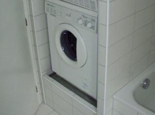
Rénovation complète d'appartements dans des immeubles anciens: Les tours de lavage des nouvelles salles de bains sont montées pour absorber les bruits solidiens et les vibrations, sur un système de masse à ressort en acier ISOWAMA-FED-W
