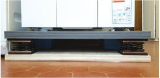
Le fonctionnement de la machine à laver posée sur la dalle en poutres au 1er étage provoque des fortes vibrations. Ces énergies perturbatrices sont réduites efficacement en isolant la machine au moyen de ressorts en acier ISOWAMA-FED-S. La répartition de la charge sur la dalle en poutres et réalisée par une plaque de répartition de charge sous les ressorts de compression en acier
