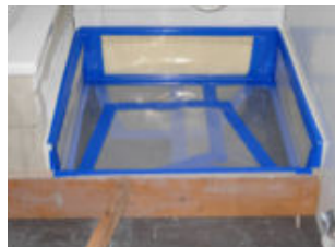
Pose de la feuille de PE pour protéger l'isolation
