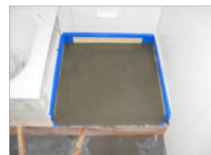
Coulage du socle de répartition de charge
