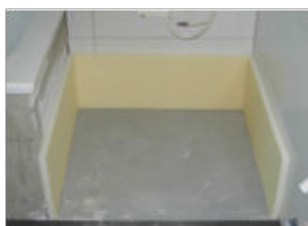
Fixation des bandes de rive ISOPE contre les murs adjacents
