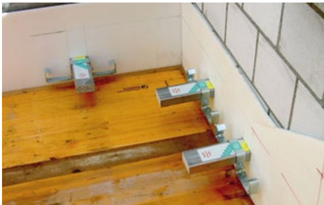
Bauweise Ortbeton: Fertig eingebaute ISOLA®-35-45-OB mit Dorn 330-X im Podestbereich. Akustische Trennung zur Wand mittels geschlossenzelligem, bauteilentauglichem Weichschaumstoff ISOPE.
