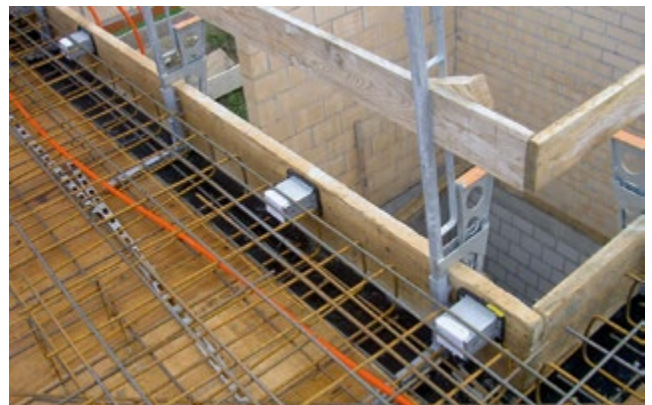
Bauweise Ortbeton: Die Schallschutzgehäuse ISOLA® 35 dB sind lagerichtig an der Abschalung zum Treppenhaukern montiert und werden in der Decke einbetoniert.
