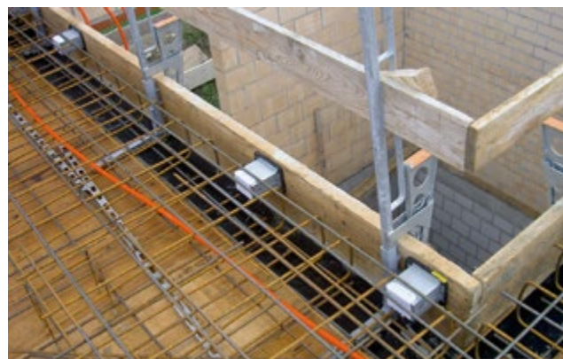
Bétonnage sur place: Les boîtiers isolants acoustiques ISOLA® 35 dB sont montés dans la bonne direction dans le coffrage du noyau de la cage d'escalier, prêts à être bétonnés dans la dalle.
