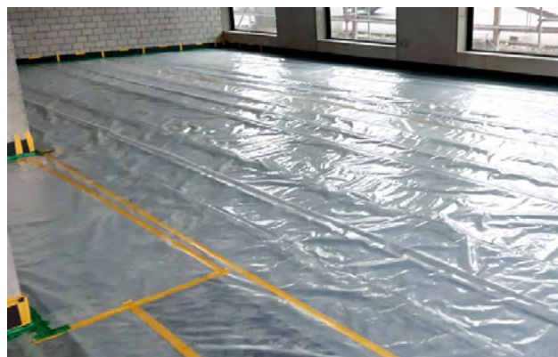
Schalldämmmaterial mit PE-Folie geschützt und dicht gegen Frischbeton verklebt
