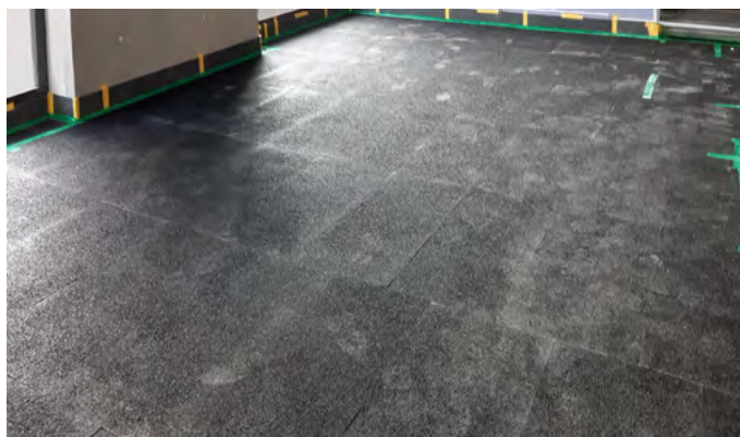
Surfaces recouvertes d'ISOPOL® et de bandes de rive avec ISOPE
