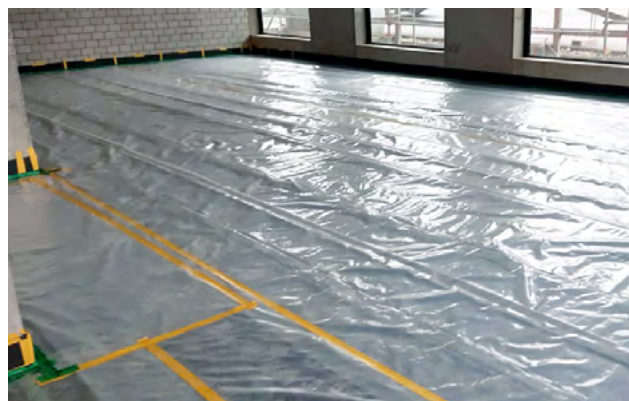
Matériau d'isolation acoustique protégé par un film PE et collé de manière étanche au laitier de ciment
