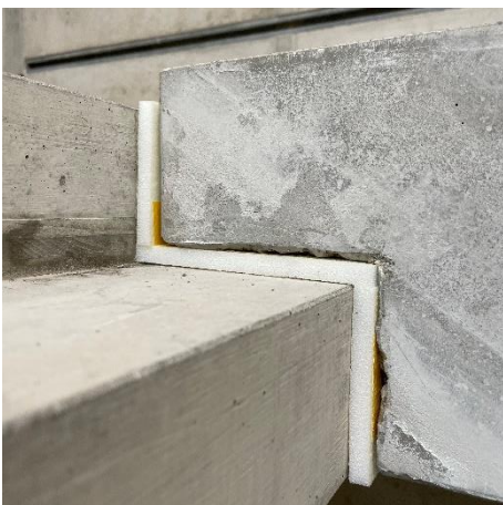
Abbildung 12: ISOTREPP® am Austritt im eingebauten Zustand (Z-Form)
