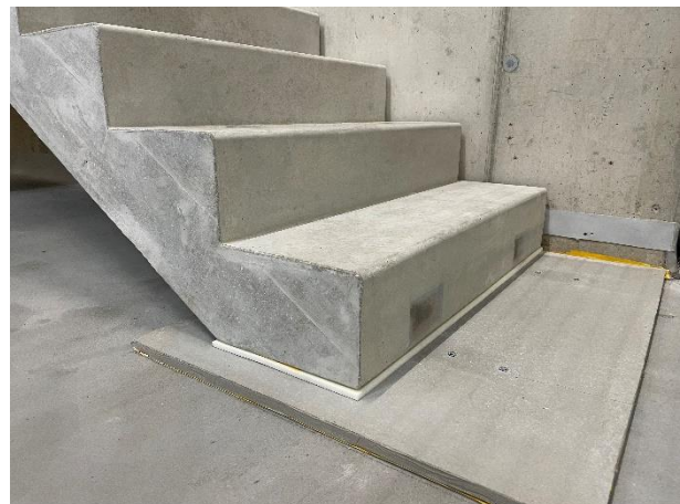
Abbildung 13: ISOTREPP® am Antritt im eingebauten Zustand (F-Form)
