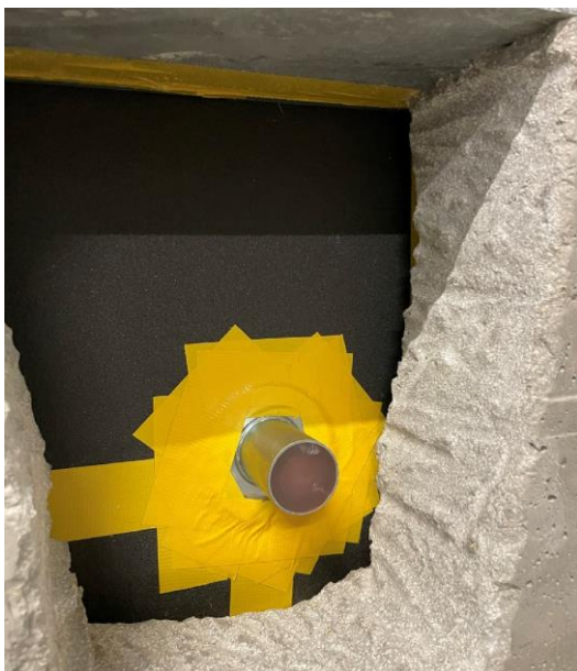
Abbildung 11: ISOSCALA®-43-10-IG vor Einbau in Wandaussparung
